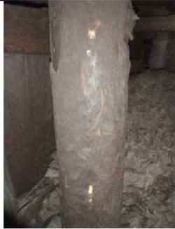
Pfahl unterhalb der Kaimauern vom Speicher D
