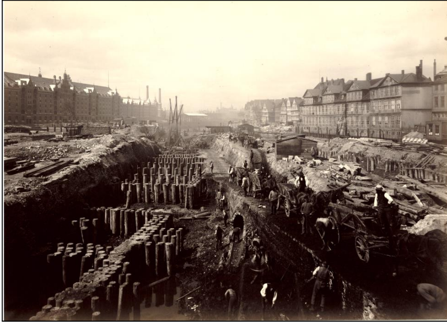
Baugrube zwischen Kannengießerbrücke und Kornhausbrücke (1887)
