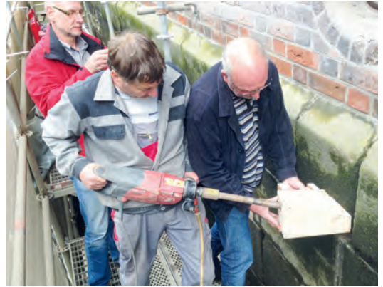
Bohrung oberhalb des Granitsockels zur Sicherung der Fassade
